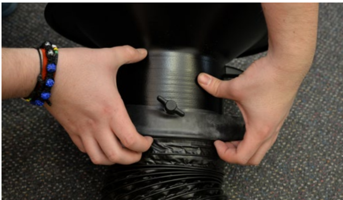
12) Přes pásku přetáhněte gumové těsnění.
